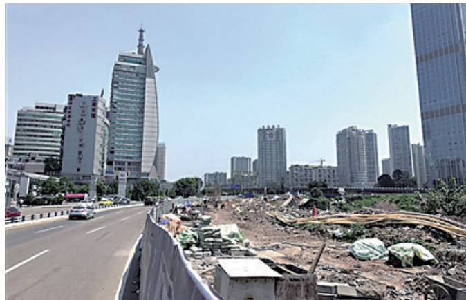
新牌坊立交 施工现场
