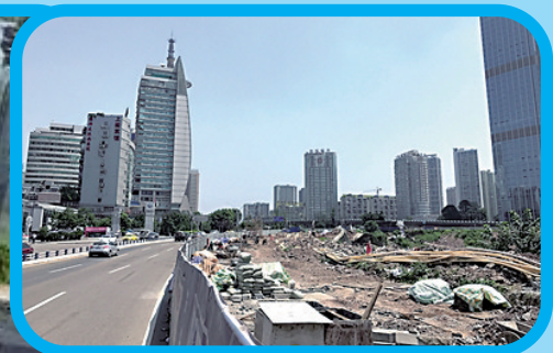
新牌坊立交施工现场
